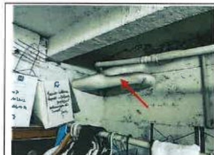
Photo n° PhA001 Localisation : Sous-Sol - Cave 2 Ouvrage : Flocages, Calorifugeages, Faux plafonds Partie d'ouvrage : Calorifugeages Description : Calorifugeages
